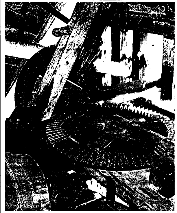
Schiffdorfer Mühle: Das Getriebe der Windrose
