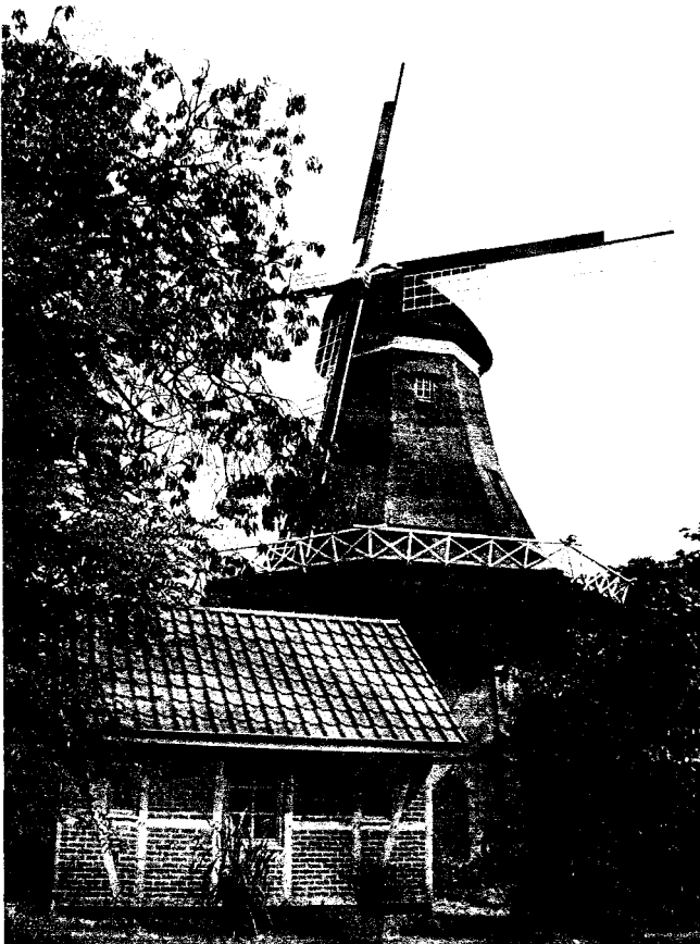
Die Mühle mit Nebengebäude nach der Sanierung
